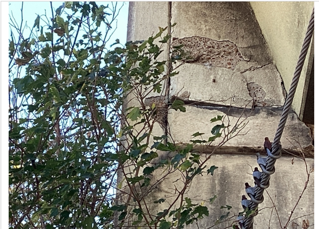
Abutment 2 spill
